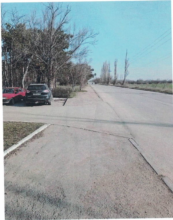
Тротуар (ул. Набережная 9)
