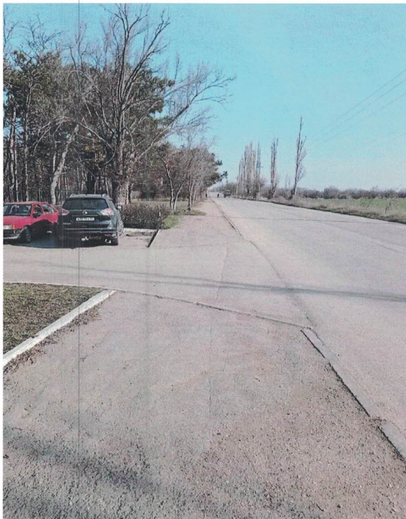
Тротуар (ул. Набережная 9)
