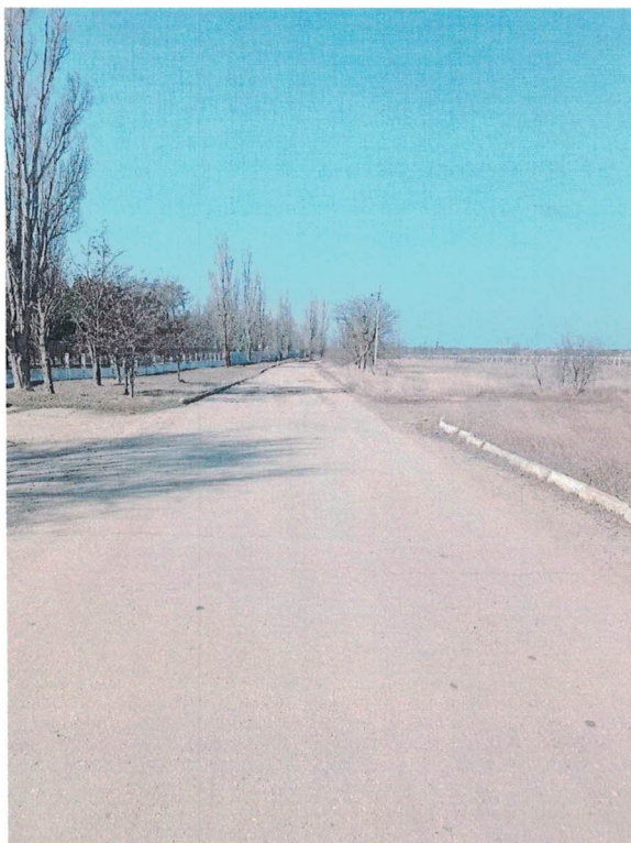
Тротуар (ул. Набережная 9)
