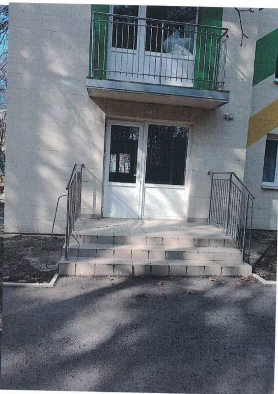
Входное крыльцо в спальный корпус
