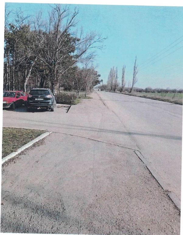
Тротуар (ул. Набережная 9)
