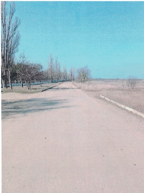
Тротуар (ул. Набережная 9)
