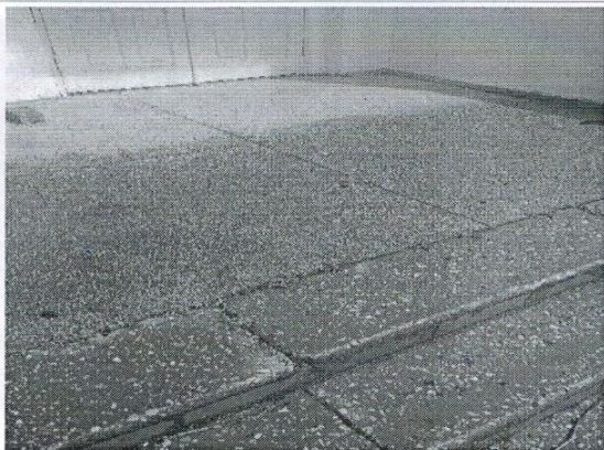
Фото № 57- лестничная площадка перед входом эвакуационным правая
