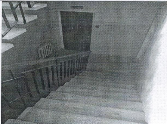
Фото № 53- лестничный марш первый этаж эвакуационный левый
