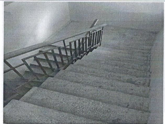
Фото № 52- лестничный марш третий этаж эвакуационный левый
