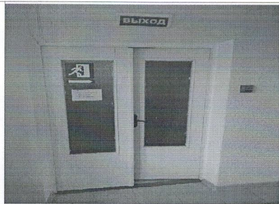
Фото №34 – дверь первого этажа эвакуационный выход правый
