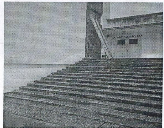
Фото № 56- лестница и входная дверь эвакуационная правая
