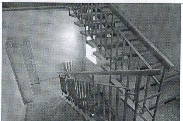
Фото № 46- лестничный марш третий этаж центральный
