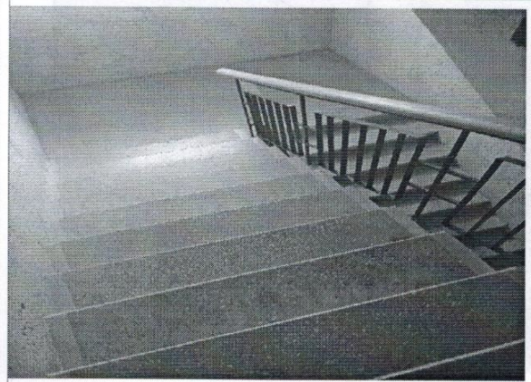
Фото № 50- лестничная площадка (эвакуационный) правый
