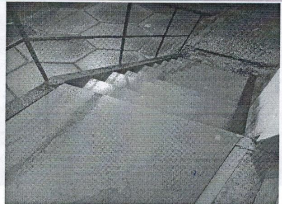
Фото № 54- входная лестница эвакуационного марша левая
