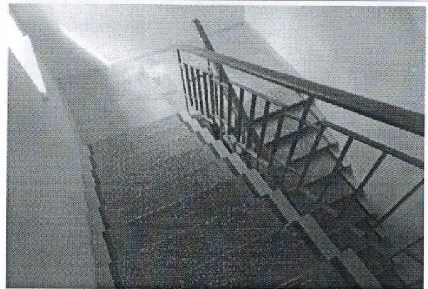
Фото № 44- лестничный марш второго этажа центральный
