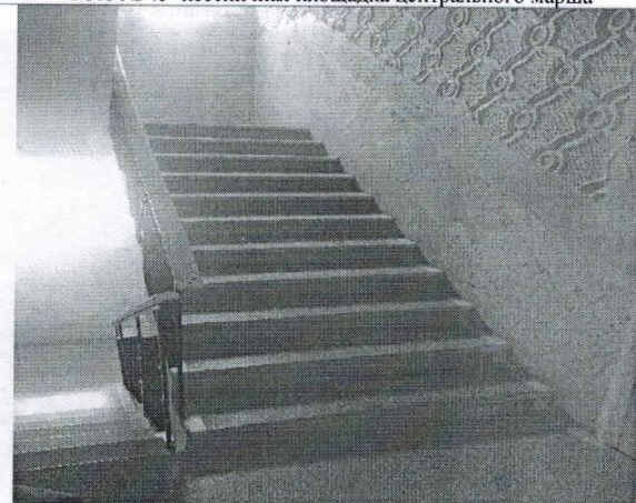
Фото № 47- лестничного марш первый этаж эвакуационный правый
