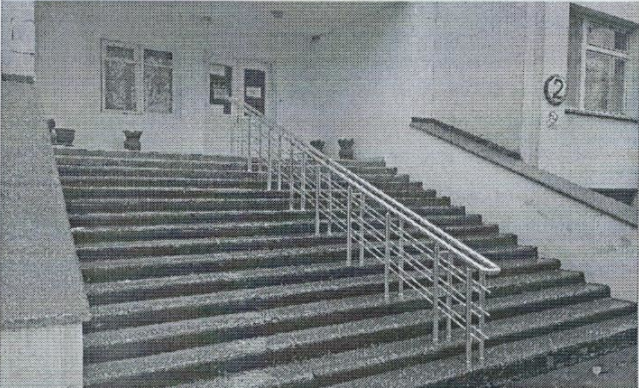
Фото №24 – вход в корпус №2 (центральный)
