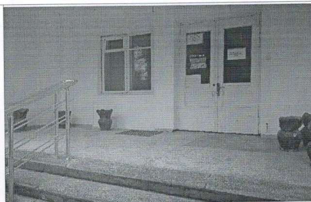
Фото №26 — площадка перед входом в корпус №2
