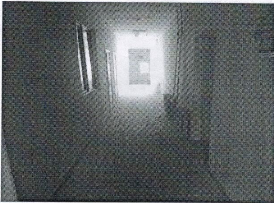
Фото № 41- коридор второго этажа
