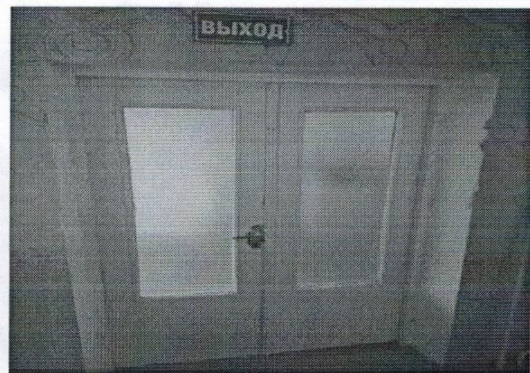
Фото №36 – дверь третьего этажа эвакуационный выход правый
