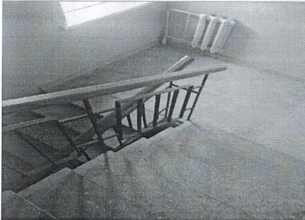
Фото № 51- лестничный марш второй этаж эвакуационный левый
