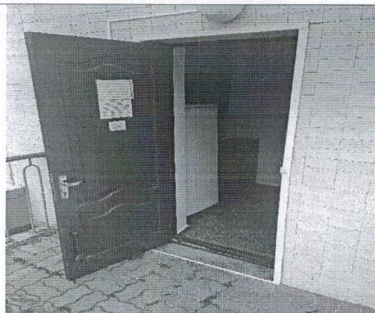
Фото №28 — входная дверь центрального входа (правая сторона)
