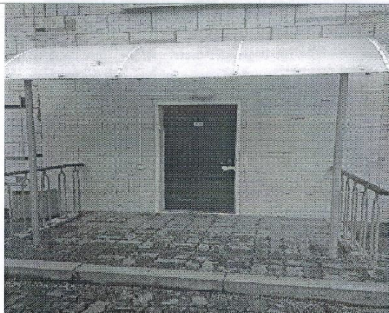
Фото №27 — входная дверь центрального входа (правая сторона)
