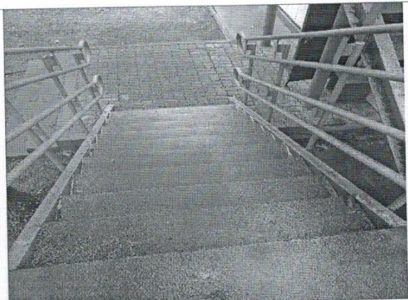
Фото №34 – лестничный марш
