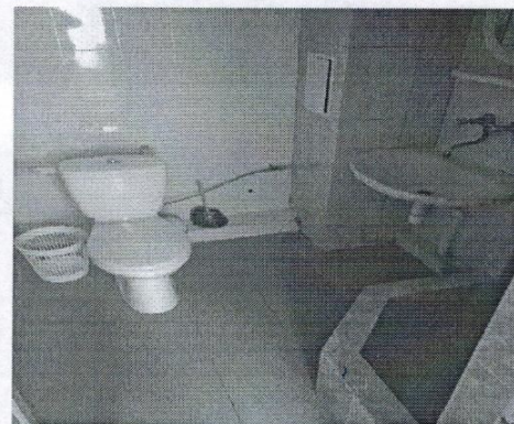
Фото № 54- санитарно – гигиеническое помещение в номере
