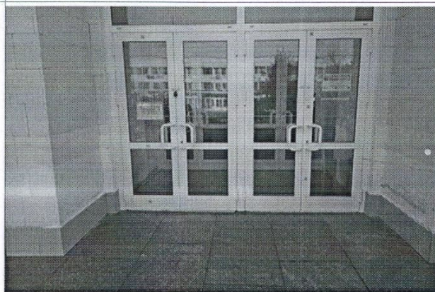
Фото №28 — Вход в здание столовой центральный
