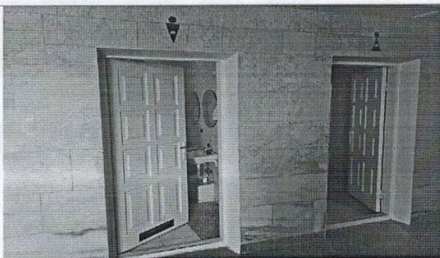
Фото №45 — Санитарно-гигиенические помещения (вход)
