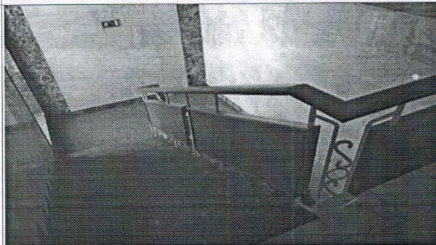
Фото № 58— лестница (правый выход)
