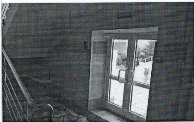
Фото №34 - Выход из здания клуба-столовой эвакуационный № 2
