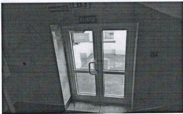
Фото №33 - Выход из здания клуба-столовой эвакуационный №1
