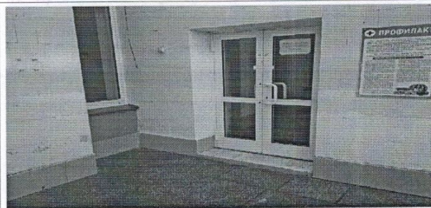
Фото №54 — эвакуационный (вход-выход) с правой стороны
